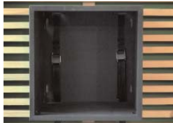
Als Verbindung dienen Spanngurte. | Lashing straps serve as the connecting elements.
